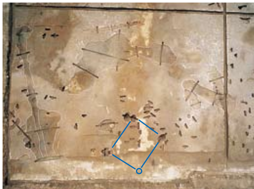
上層 平地建物SI2428 (上空北から)
