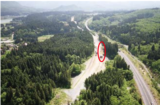
右は磐越自動車道、左は国道49号揚川改良工事（西から）
