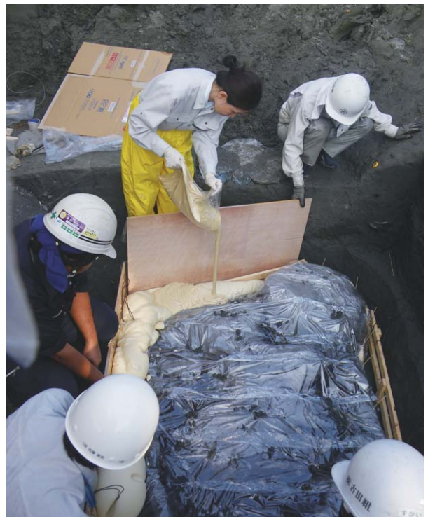
写真2 土坑と型枠の間にウレタンを充填している様子
