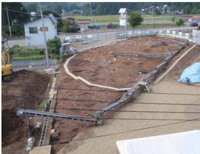
全景(南東から)
