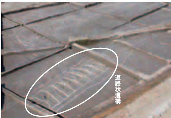
東西大畦畔と道路状遺構(南西から)
