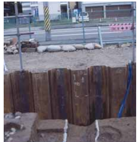
2 白線屋敷境の溝 家の切れ目が現在の町境
