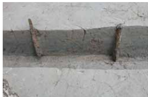
杭検出状況(南から)
