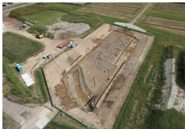
● 調査区 全景（上空南西から）
