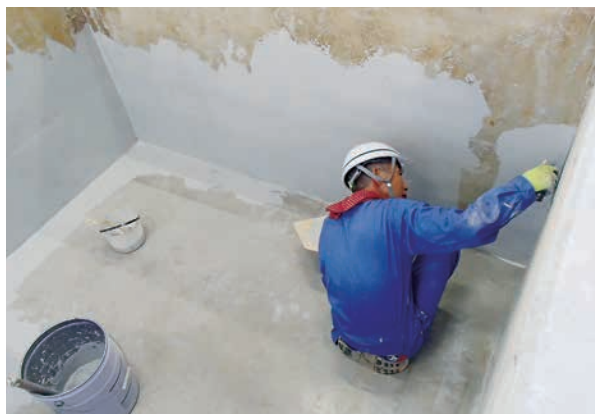
● 木製品保管水槽の塗替え工事
