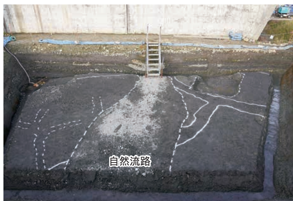
● 南区下層畦畔（南東から）
