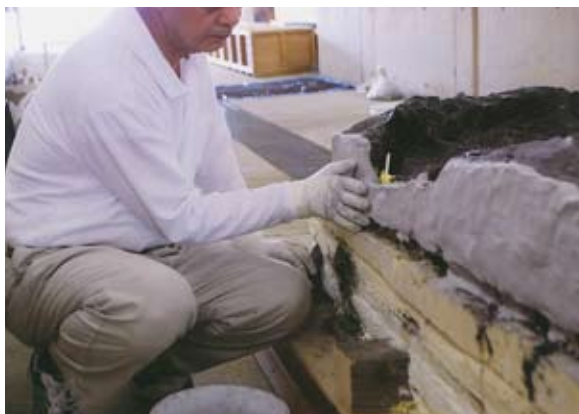
軽量エポキシモルタルによる側面の強化
